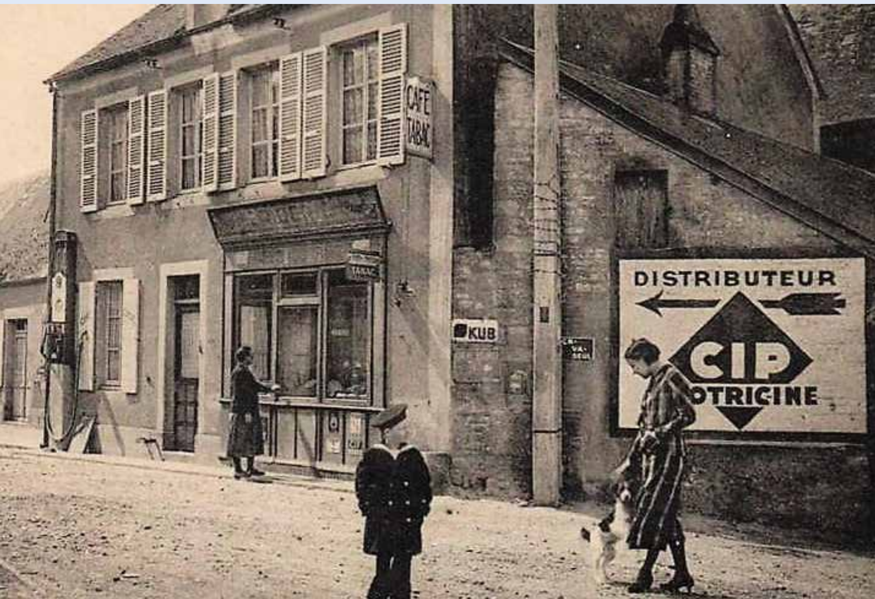
Photo de gauche : Vous aurez remarqué le bi jaugeur scellé dans le mur à l'extrême gauche du bâtiment.
